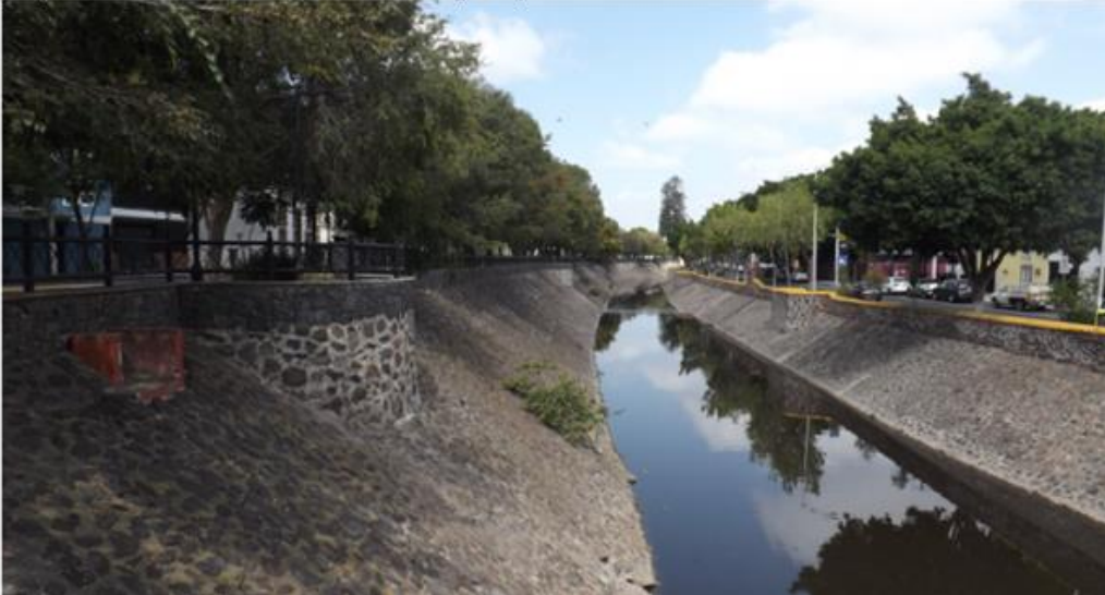
Imagen 4. Infraestructura de mejora urbana diferenciada en ambos márgenes del río Querétaro Fuente: Héctor Martínez-Ruiz, 2021.
